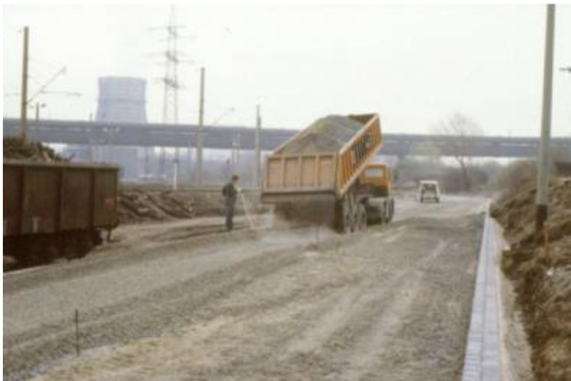
Bild 7: Hochofenschlacke im Straßenbau (Tragschicht) [Lit 14]
