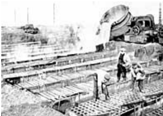
Bild 11: Herstellung von Pflastersteinen aus Hochofenschlacke, ca. 1920 [Lit 14]
