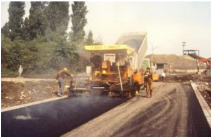
Bild 6: Einsatz von Stahlwerksschlacke als Gesteinskörnung in bitumengebundener Deckschicht [Lit 14]
